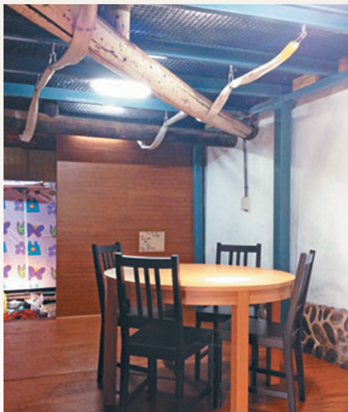
經過李承翰改造後，不但變成鋼構，且室內明亮許多。圖／李承翰提供
