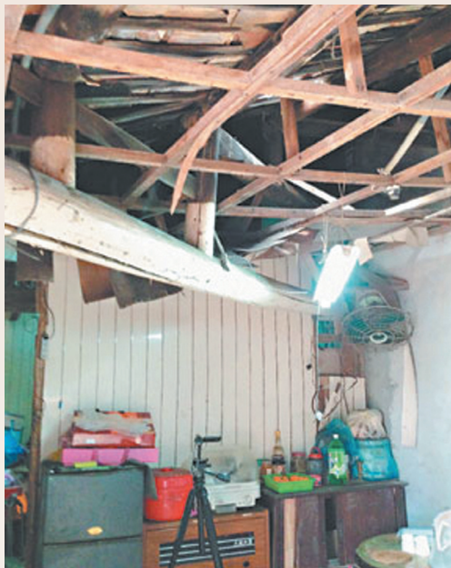
整修前土角厝下雨就漏水、梁柱也快斷了。圖／李承翰提供
